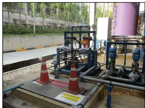
ภาพถ่ายที่ 2.2-14 บ่อปรับสภาพให้เป็นกลาง (Neutralization pit)
