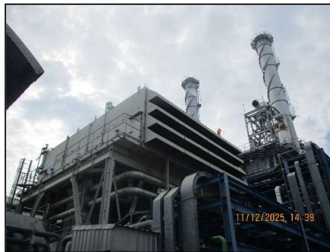
ภาพถ่ายที่ 2.2-5 Silencer ทางออกไอเสีย ของเครื่องกังหันก๊าซ
