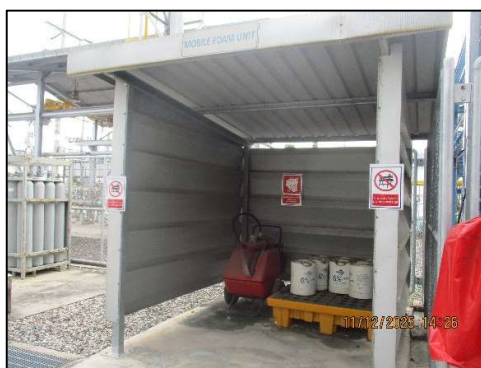
ภาพถ่ายที่ 2.2-40 ถังฉีดโฟมเคลื่อนที่ (Mobile Foam Unit)
