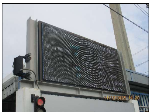
ภาพถ่ายที่ 2.2-3 จอแสดงผลตรวจวัดคุณภาพอากาศจากปล่องโรงไฟฟ้า
