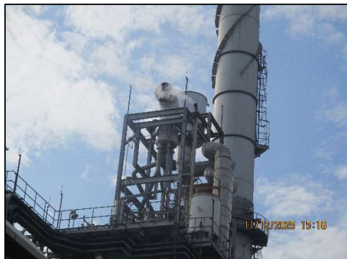
ภาพถ่ายที่ 2.2-4 Silencer ทางออกไอเสีย ของเครื่องกังหันไอน้ำ (Steam blow)
