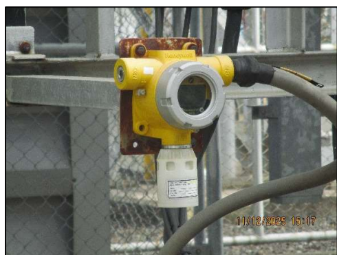
ภาพถ่ายที่ 2.2-31 ระบบป้องกันการรั่วซึมของก๊าซ (Gas Detector)
