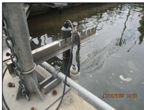
ภาพถ่ายที่ 2.2-13 Level Switch บริเวณบ่อพักน้ำทิ้ง
