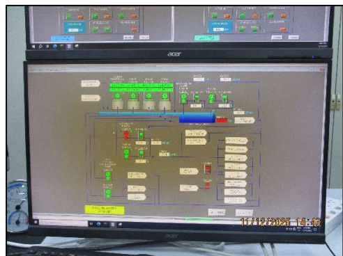
ภาพถ่ายที่ 2.2-12 หน้าจอแสดงระบบตรวจสอบอุณหภูมิของน้ำหล่อเย็น
