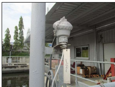
ภาพถ่ายที่ 2.2-19 เครื่องวัดอุณหภูมิอัตโนมัติ
