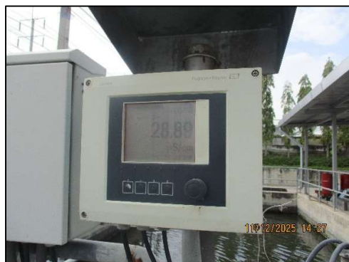
ภาพถ่ายที่ 2.2-18 เครื่องวัดค่าความเป็นกรด-ด่าง และเครื่องวัดค่าการนำไฟฟ้าแบบอัตโนมัติ
